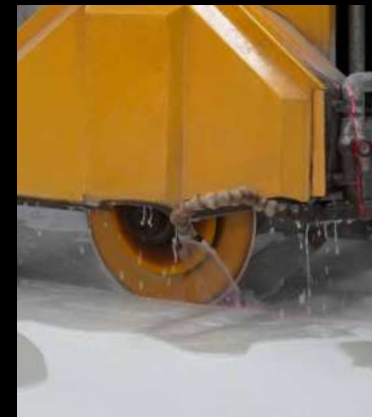
WATER JET & CUSTOMISE STONE CUTTING บริการตัดหิน
